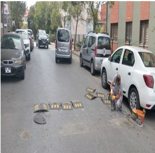
Etiler Mahallesi, Gülal Sokak Hız Kesici Montaj Çalışması
