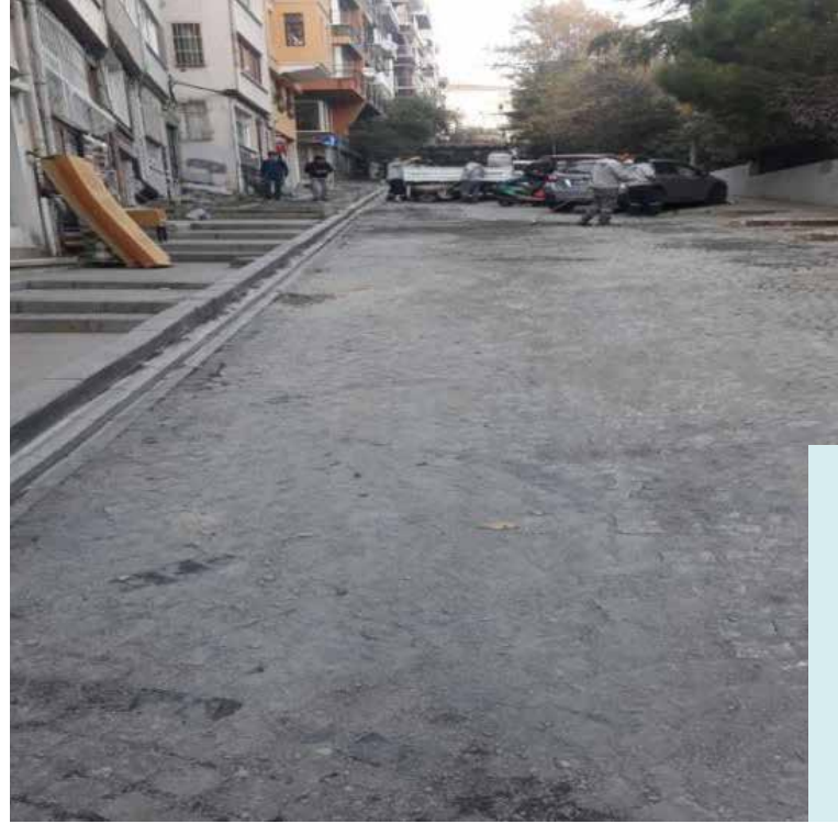
Abbasağa Mahallesi, Maşuklar Yokuşu Yol Onarımı
