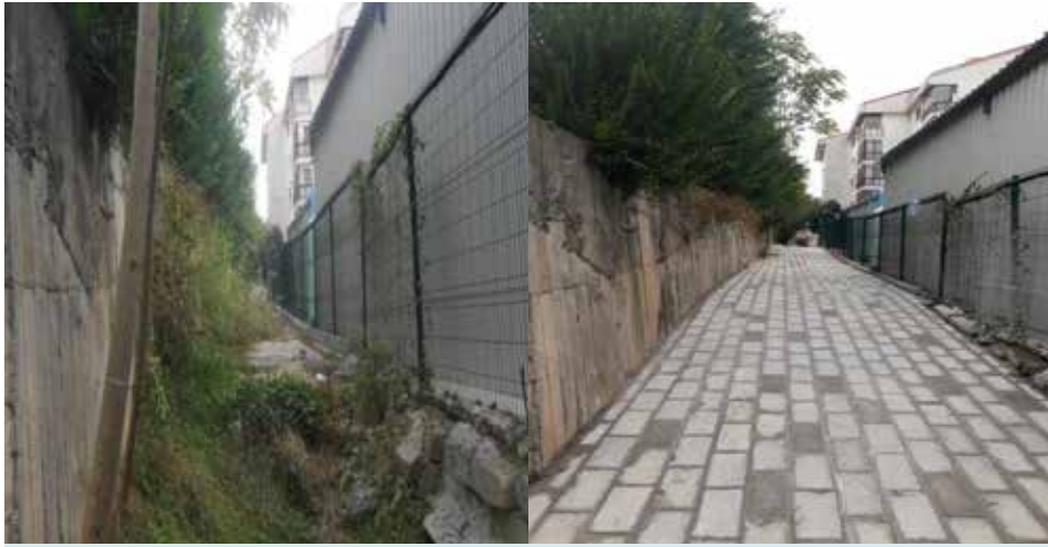
Ulus Mahallesi, Bronz Sokak Yol Yenileme Çalışması
