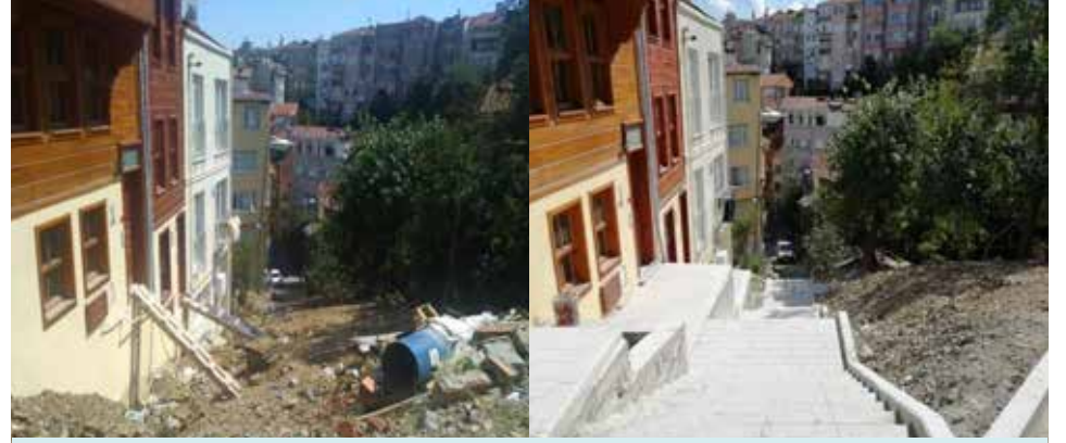
Vişnezade Mahallesi, Solgun Söğüt Sokak Merdiven Yapımı ve Düzenleme Çalışması
