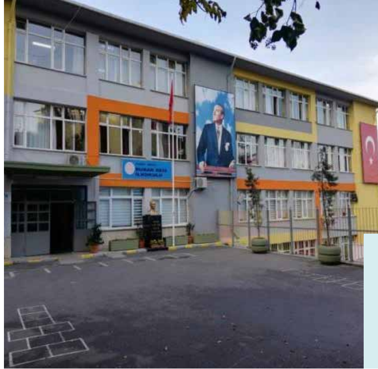
Burak Reis İlkokulu Dış Cephe Boyası
