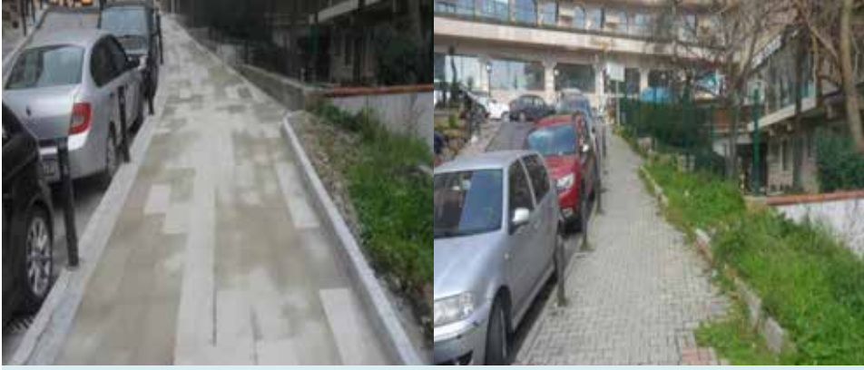
Nispetiye Mahallesi, Aydın Sokak Kaldırım Yenileme Çalışması
