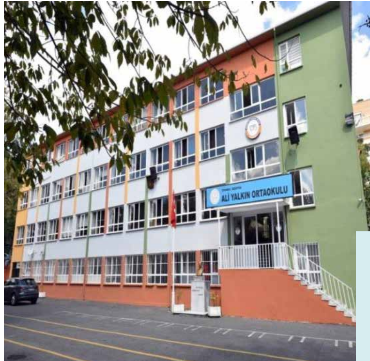
Ali Yalkın Ortaokulu Dış Cephe Boyası
