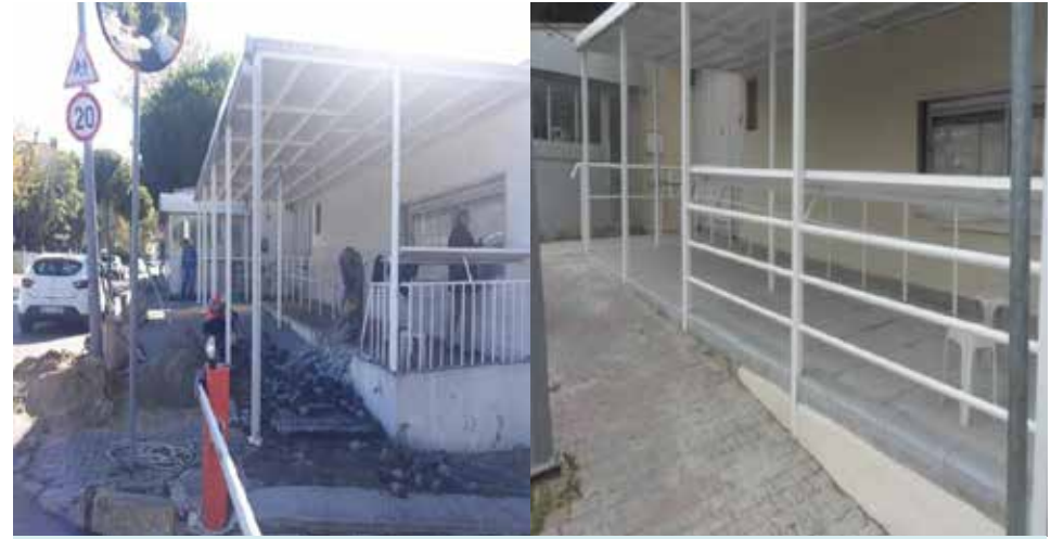
Kültür Mahallesi, Ahmet Adnan Saygun Caddesi Kaldırım Düzenleme Çalışması
