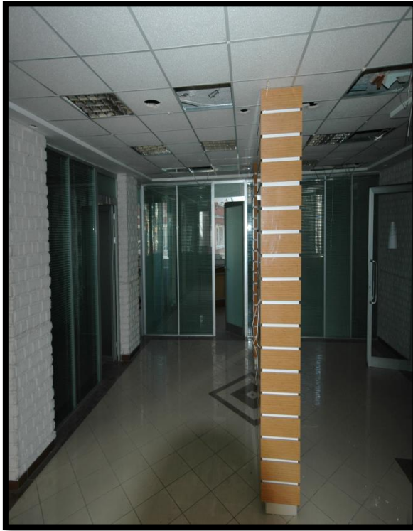
Kızılay Binası mevcut durumu
