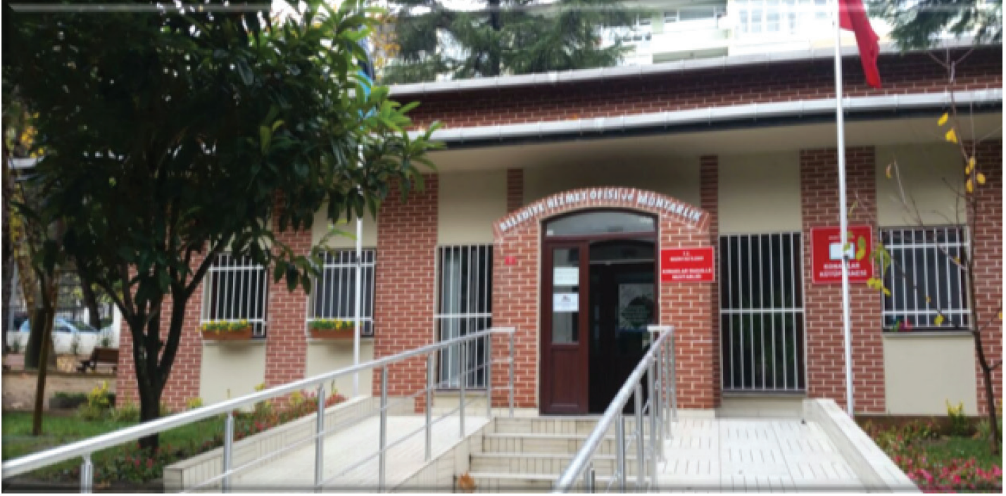
Konaklar Mahalle Muhtarlığı mevcut hali
