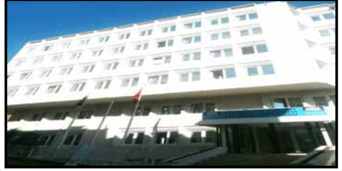
Bina Dış Cephe Genel Görünüş
